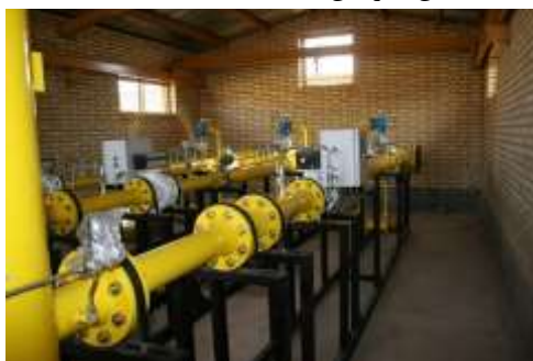
شکل ۱. نمونه‌ای از ایستگاه‌های تقلیل فشار گاز شهری
